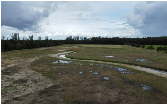
Afbeelding 3. Slenk met lichte ontgraving en verontdieping van huidige sloten.
